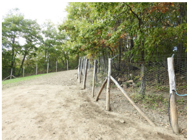
Figura 2 - Ricovero notturno realizzato con rete paramassi
