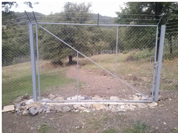
Figura 5 - Cannello realizzato con rete paramassi e antisalto con filo spinato; base del cancello con antiscavo
