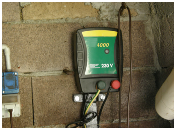
Figura 8 - Elettrificatore per allaccio a corrente elettrica fissa
