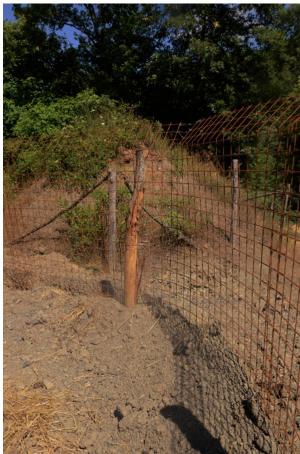
Figura 6 - Esempio di realizzazione di angoli stondati
