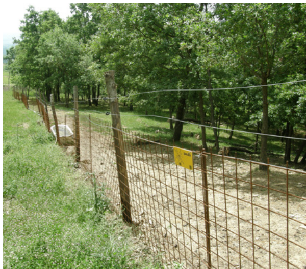
Figura 19 - Recinzione mista con base realizzata in fogli di maglia elettrosaldata interrata e parte superiore costituita da fili per conduzione elettrica
