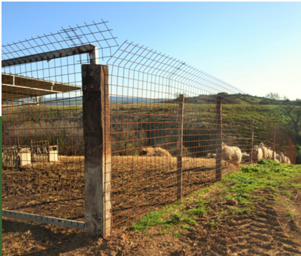
Figura 4 - Ricovero notturno con rete elettrosaldata con antisalto (piegatura esterna di 30 cm) e interrato di 30 cm; cancello antipredatorio realizzato con rete elettrosaldata
